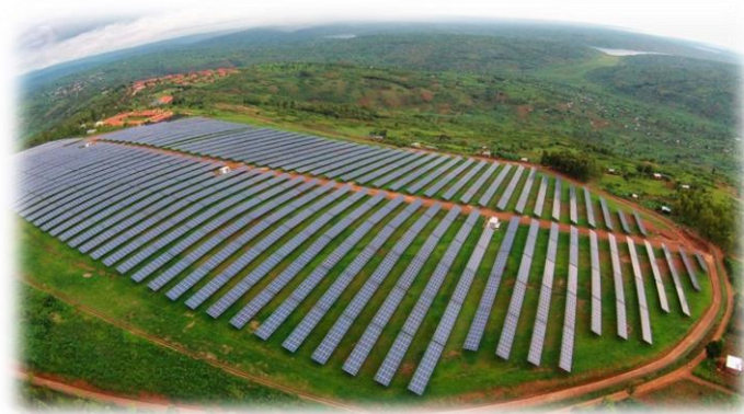
キガリ近郊に建設され大型太陽光発電所(発電能力8.5MW)
